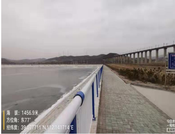
调蓄库南侧现状
